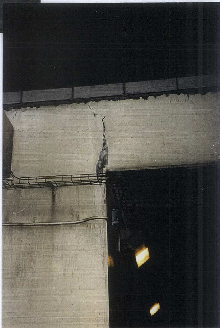
Photo n° 6 Fissure à l'angle de la dalle et de l'appui central
